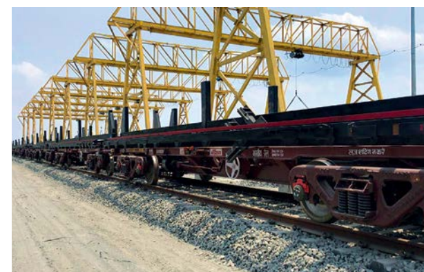
インド貨物専用鉄道西回廊 土木・軌道工事
