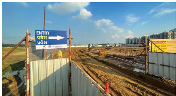
ムンバイ～アーメダバード間高速鉄道(車両基地建設予定地)
