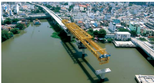
【鉄道インフラ敷設】ベトナム・ホーチミン地下鉄1号線高架土木工事
