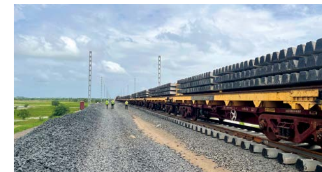
デリー～ムンバイ間貨物専用鉄道(軌道敷設風景)
