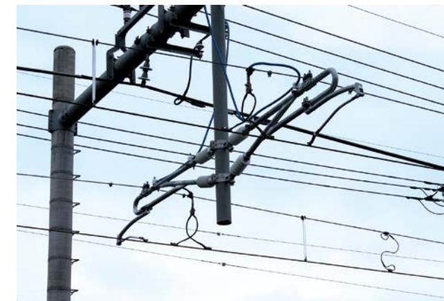
コネクタ金具(袋ねじ形、クランブイヤー形)
